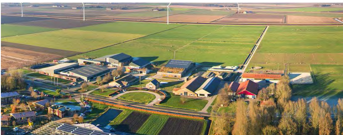
Het Aeres Praktijkcentrum Dronten met links het trainingsbedrijf, in het midden de melkstallen er rechts de gebouwen van de studentbedrijven. Op de achtergrond zijn de landerijen en de windmolen van EWI te zien.
